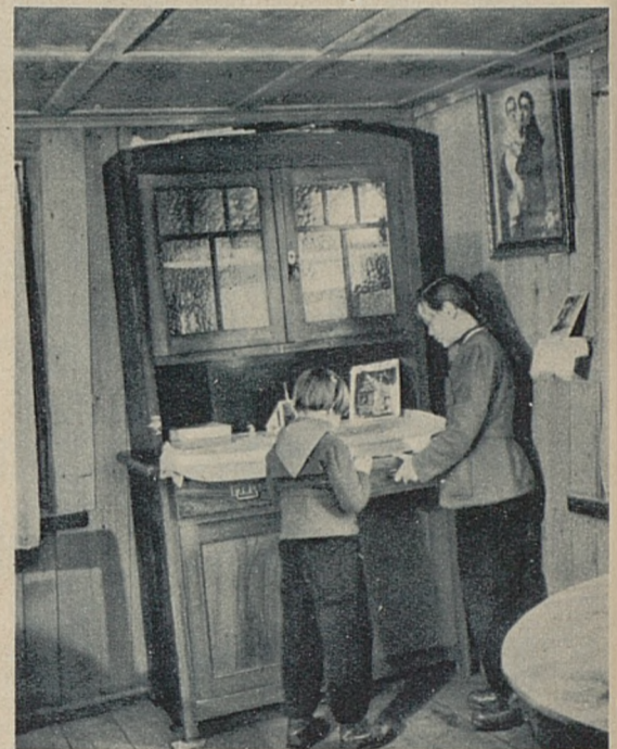
A Peiden, on ne sait plus ce que sont les planchers horizontaux ni les meubles d'aplomb. Fenêtres et portes sont disjointes. Différentes commissions ont visité les maisons du village. Elles en ont tiré la conclusion que les conditions de vie dans de tels logements empiraient de jour en jour.
