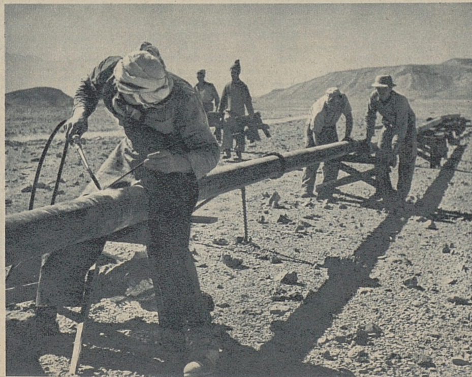
Pour amener à la raffinerie, située près du port d'embarquement, le pétrole des puits disséminés dans la région, des centaines de kilomètres de « pipe-lines » durent être posés dans le désert. On a commencé de les réparer en vue de leur remise en activité.
