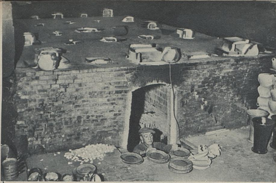
△ Le plus grand four se trouve dans l'atelier Saltalamacchia, où l'on fabrique surtout des articles de cuisine. Le système des fours est le même qu'il y a cinq siècles. On les chauffe au bois et leur température atteint 800 degrés. Les fours électriques modernes ne sont pas très appréciés par les potiers, car la température n'est pas aussi forte que dans les vieux fours à bois.
