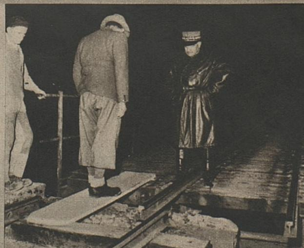
Le premier mouvement a commencé. Le pont a lentement glissé sur la droite, vers la nouvelle culée préparée tout exprès. On distingue, au premier plan, l'ancienne culée. A considérer les rails du pont et ceux de cette culée, on constate que l'ouvrage a déjà avancé d'un mètre environ. — Le colonel divisionnaire Petitpierre assiste aux travaux. - (I. 7161)
