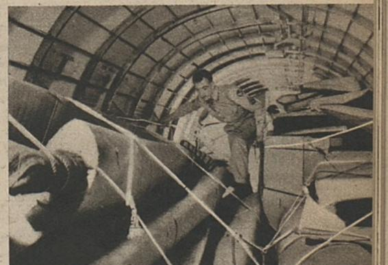
Un caporal-pilote de l'« Air Transport Command » surveille, en cours de vol, l'arrimage d'ailerons de rechange.
