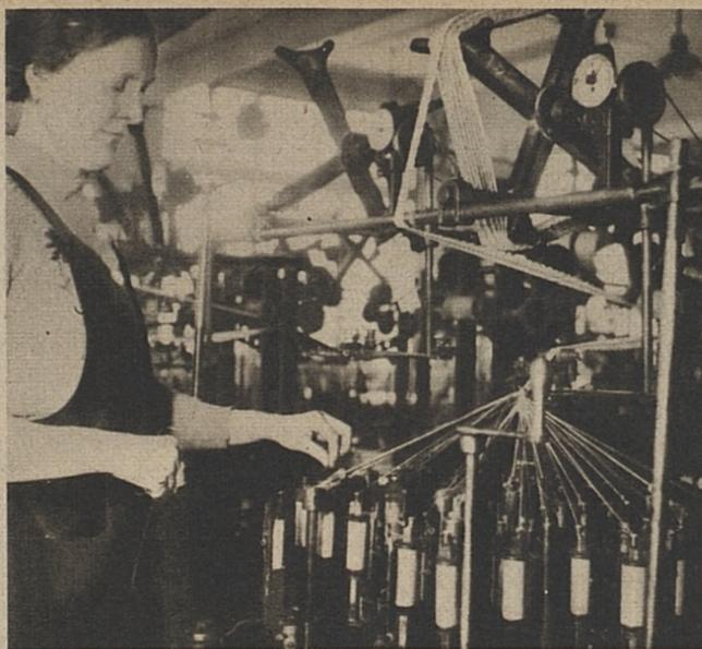
Cette machine tresse les bandelettes de cellulose en un large ruban dont l'aspect pourra être modifié à volonté selon le dessin de l'échantillon.
