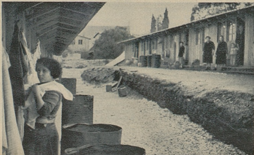
L'œuvre de reconstruction a déjà accompli des prodiges dans les îles dévastées. Ces baraques ▽ de bois assurent à leurs occupants un abri qu'ils apprécient malgré son confort relatif.
