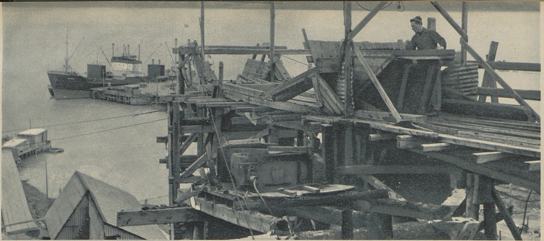
Un téléphérique amène le charbon à Longyearbyen jusqu'à la grande centrale de distribution du port. De là, la houille est transportée par vagonnets jusqu'à un vaste entonnoir d'où elle tombe sur une bande sans fin qui la fait glisser par les écoutilles des cargos. Le charbonnier que l'on aperçoit à gauche s'apprête à regagner la Norvège avec 15 000 tonnes de charbon dans ses flancs.
